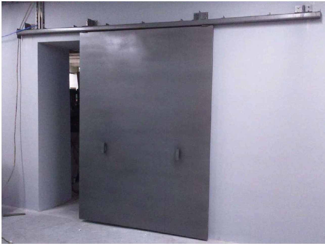
ВОГНЕСТІЙКА МЕТАЛЕВА ШТОРА ШВИДКОГО РЕАГУВАННЯ, ЗАХИСТ ПРИМІЩЕННЯ ВІД РОЗПОВСЮДЖЕННЯ ВОГНЮ
